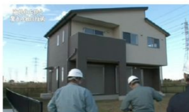
住宅の傾きもなく、ほとんど沈んでいないことが実証されました。
