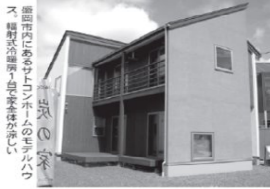
盛岡市内にあるサトコンホームのモデルハウス。輻射式冷暖房一台で家全体が涼しい。
