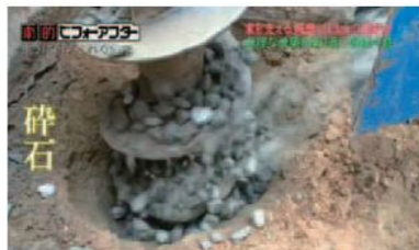
早速砕石を投入、地中に砕石パイルを施工します。
