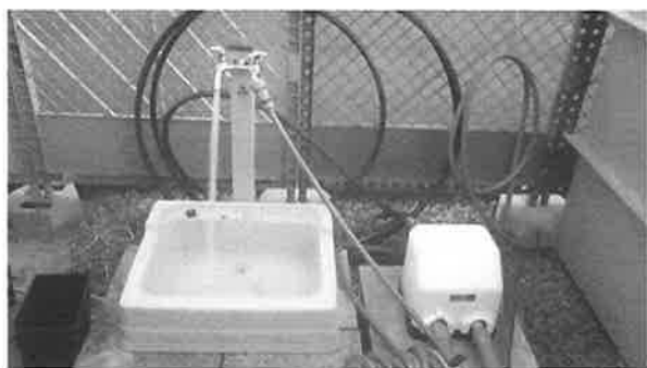
図-10 地下水のくみ上げ状況
