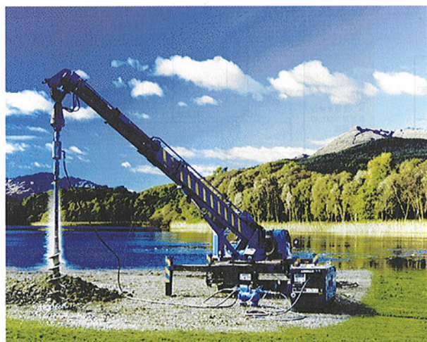
写真-1 施工状況
